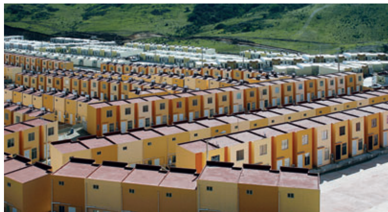
Viviendas económicas, Casas Geo/México: producción de 40 viviendas por día
