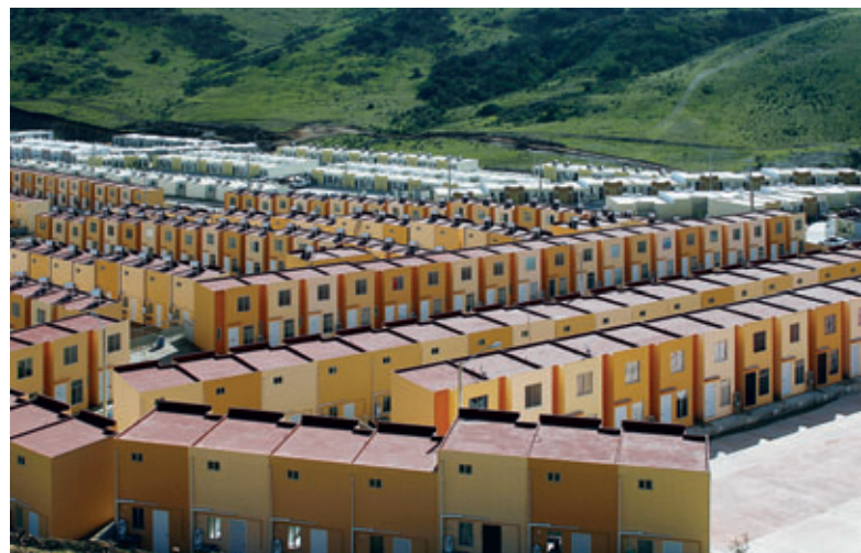
Low-Cost-Häuser – Casas Geo/Mexiko: Produktion von 40 Häusern pro Tag
